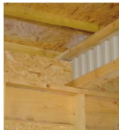
Pose en chevrons avec débord de toit (toiture à faible pente).
