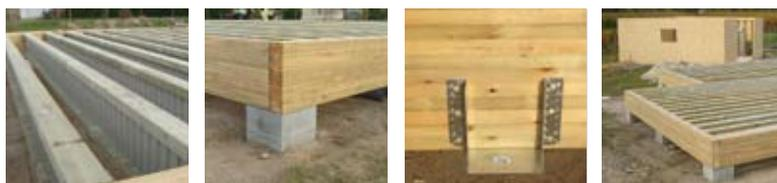
Solivage en vide sanitaire - Membrures préservées classe 3 - Portée maximum : 8,70 m sur 2 appuis en périphérie (suppression d'appui intermédiaire) - Pose sur lamellé-collé périphérique préservé classe 3 - Pose sur étrier standard avec blocage sur membrure haute par équerre.
