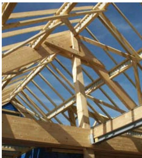
Pose en pannes sur charpente traditionnelle - Pose à l'aplomb
