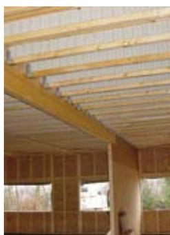
Solivage - Pose sur sabots entre lamellé-collé porteur
