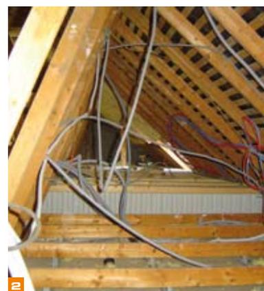
2 Mise en œuvre du doublement des fermettes
