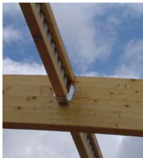
Pose en pannes sur lamellé-collé cintré avec sabots métalliques
