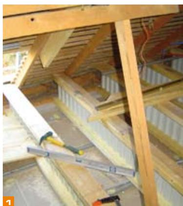
1 Accès simple par une trappe découpée dans le toit - Repose des poutres sur le mur en extrémité
