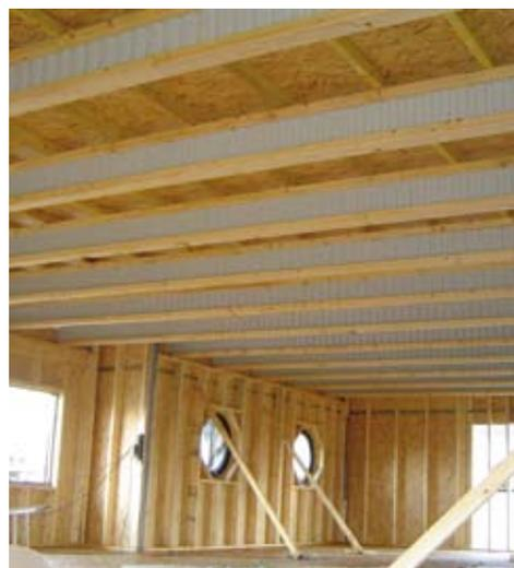
Toit plat pente faible de 1 à 3 % - Support plafond et d'étanchéité (toiture terrasse inaccessible) - Entraxe maximum de 120 cm
