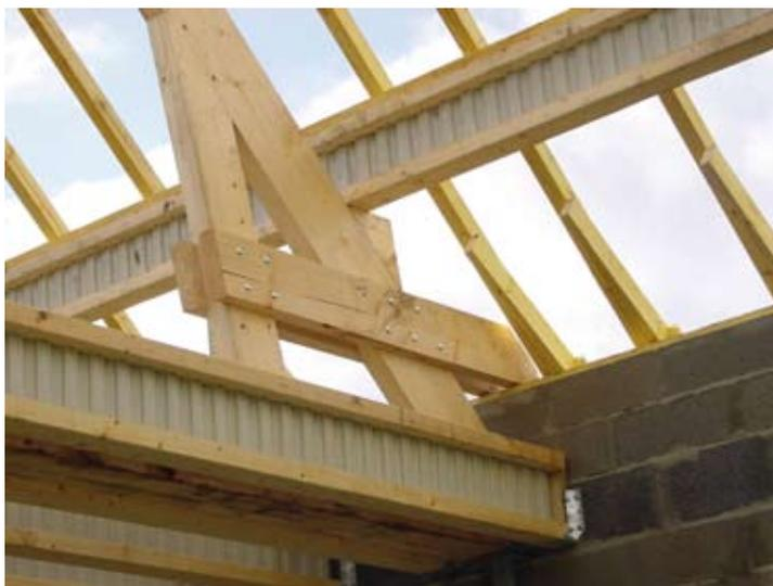
Pannes sur charpente traditionnelle - Pose à l'aplomb avec cale d'appui et stabilité par feuillard (feuillard non posé au moment du cliché)
