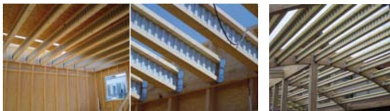
Pose en chevrons: toiture toit plat support d'étanchéité, pente faible à 3 % - 2 sabots pour éviter le soulèvement
